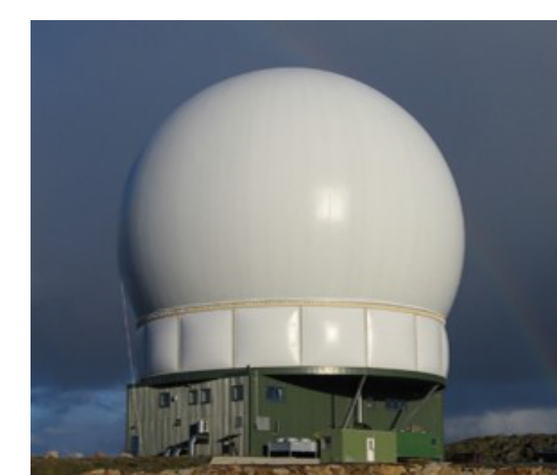
エアサポートドーム
