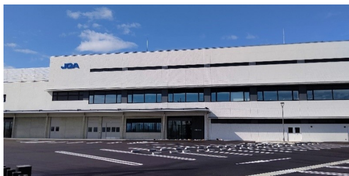
JQA 中部試験センター
