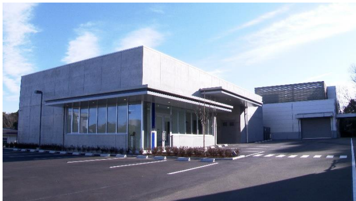
JQA 車載機器専用 EMC ラボ (安全電磁センター)
