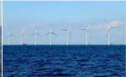
沖合風力発電システム全景
